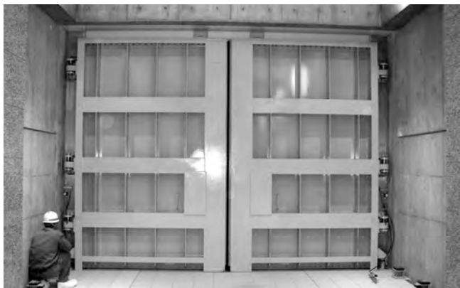
会 員 名:丸島産業 (株) 製 品 名:両開き防水扉 (形式:鋼製マイターゲート) 製 品 特 徴:ゲートの両側に取り付けられたヒンジ金物で、非常時に両扉をスイングさせて閉鎖します (設計水深:8.96m (正圧))。
