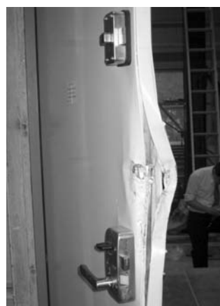
▲パールによるこじあけで戸先側が歪んだドア
