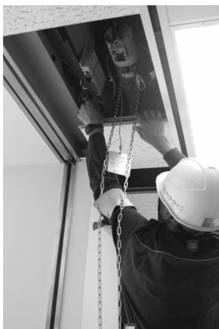
管理用シャッターの機構部を点検
