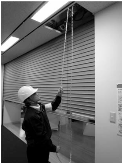
作動、降下確認後のチェーン機構による巻き上げ作業
