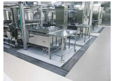
▲防水板（脱着式）
