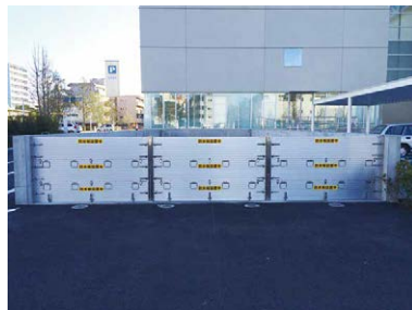
▲防水板（脱着式）
