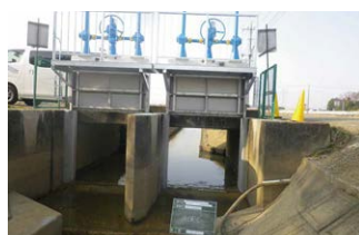
▲ H18 埼玉県発注加須農林調整ゲート
