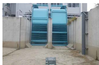
▲ H18 埼玉県発注熊谷県土除塵機
